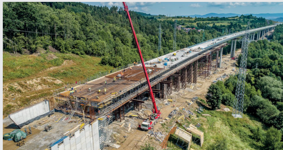
▲ EST1 w trakcie realizacji; skrzydła przyczółka połączone z murem oporowym MO-10.
