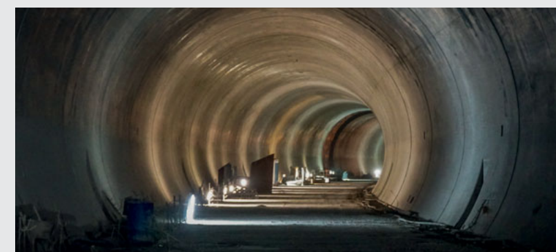
▲ ▼ Przekrój obudowy ostatecznej: wys. 7,8 m szer. 11,9 m.
