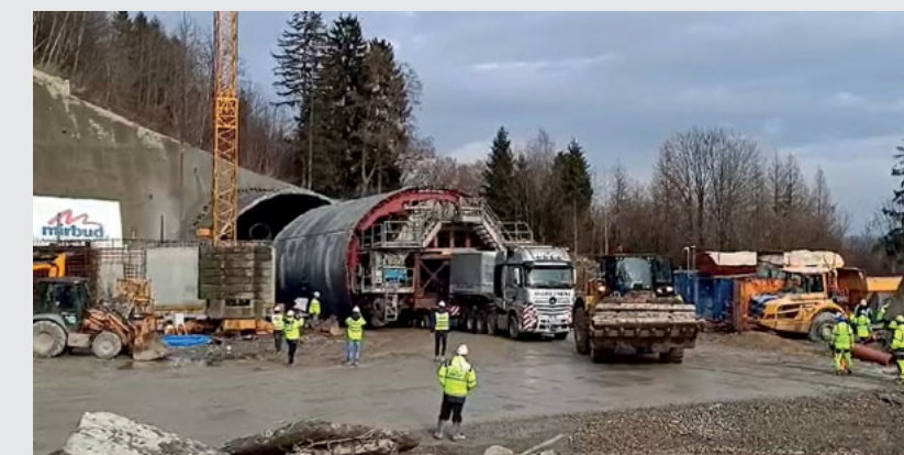
▲ Wyjazd szalunku z tunelu TD1.1 i przewóz do tunelu TD2.1
